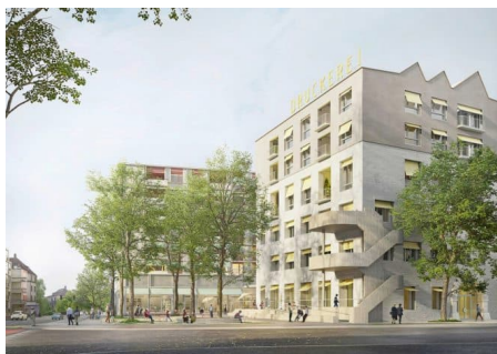
Linkerhand wird ein Quartierplatz entstehen, daneben wird eines der bestehenden Gebäude saniert und aufgestockt.
